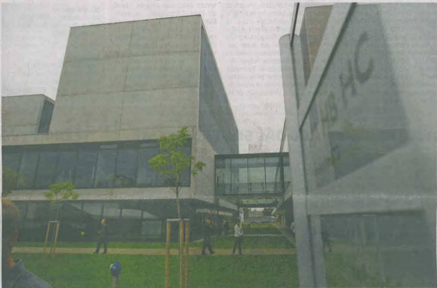
BUDOVA FAKULTY chemicko-technologické Univerzity Pardubice už stojí na svém místě. Bylo na to ale potřeba více času a peněz, než se původně předpokládalo... Jak to dopadne s dalšími budovami pardubické univerzity v Polabinách a v centru Pardubic? Dva nové projekty slibují, že do konce akademického roku 2015/2016 bude vše dokončeno a náklady se údajně nezvednou. Foto: Deník/Luboš Jeníček
